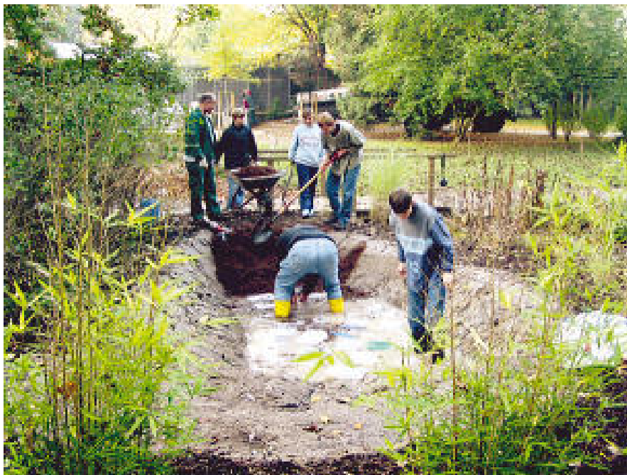
Die durchlöcherten Essig- und Ölskanister am Grund des künftigen Hochmoores im Hofgarten wurden mit Torf bedeckt. (Foto: Gerhard Gutbrod)
